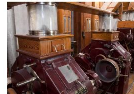
3.1 ΕΝΟΤΗΤΑ Ε.3 ΒΙΟΜΗΧΑΝΙΚΗ ΕΠΕΞΕΡΓΑΣΙΑ 3.1.2 ΕΝΟΤΗΤΑ Ε.3 ΤΜΗΜΑ ΑΛΕΣΗΣ
